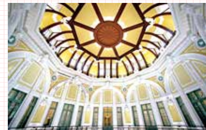
東京駅丸の内駅舎のドーム屋根の天井部
