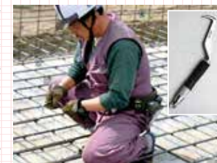
結束作業とハッカー(右上) 提供:東京都鉄筋業協同組合
