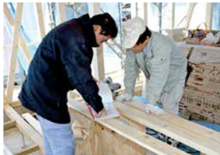
建築の実務。図面を見ながら木材を加工します。
