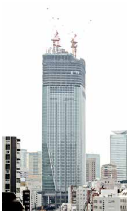
都内で建設中の大型再開発ビル。タワークレーンで必要な資機材を吊り上げます。
