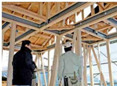
住宅の骨組みが出来上がってきました。
