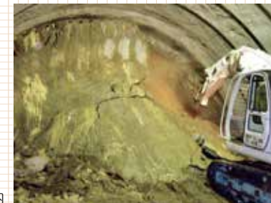
トンネルの坑内
