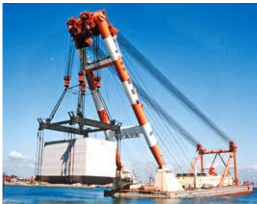
起重機船でケーソンを吊り下げて所定の位置に設置する。
