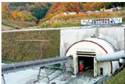
山岳トンネルの坑口。土砂を排出するコンベアと換気のための換気管が坑内から出ています。
