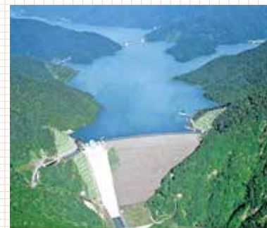
岐阜県にある徳山ダム。総貯水容量・堤体積で国内最大のロックフィルダム。岩石の内側にある土によって水を堰き止めている。
