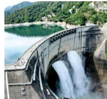
日本一の高さ(186m)を誇るアーチ式コンクリートダム「黒部ダム」(富山県)。
