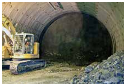
山岳トンネルの掘削状況。掘削している先端部分は「切羽」(きりは)と呼ばれています。
