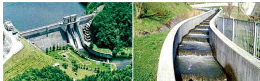
さまに ダムと階段式魚道。魚道の途中に階段を上っていく魚が見られる窓が設けられている。 提供：水資源環境センター
