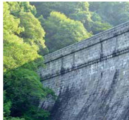
日本初の重力式コンクリートダム「布引五本松ダム」(1900年竣工/神戸市)。
