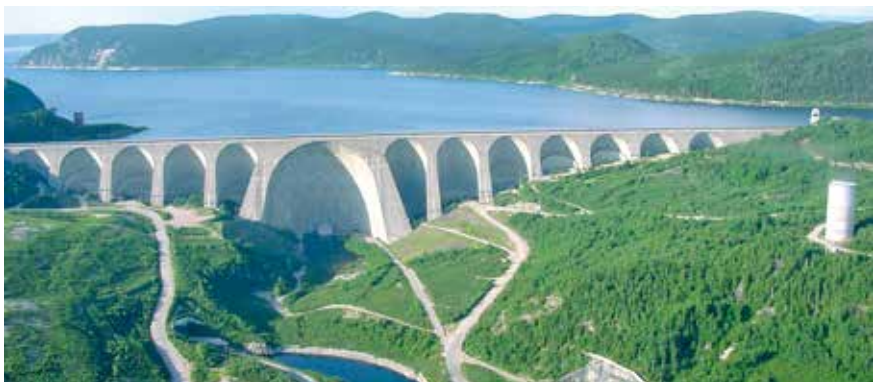
カナダにあるダニエル・ジョンソンダム。「バットレス」と呼ばれる形式で、美しいダムとして世界的に知られている。 © 2012 lmgur, LLC
