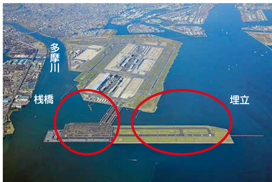
羽田空港D滑走路。栈橋と埋立のハイブリッド構造。
