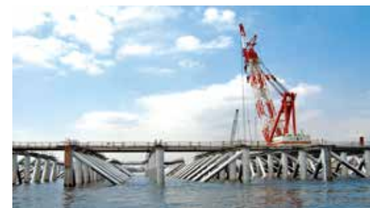
栈橋下部(施工中)
