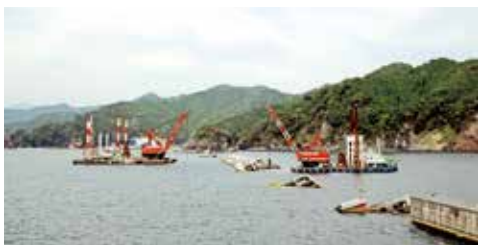
釜石港(岩手県)の湾口防波堤の復旧工事の様子。
