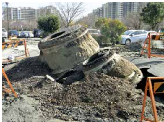
東日本大震災ではマンホールが大きく浮き上がった場所もある(千葉県浦安市)。
