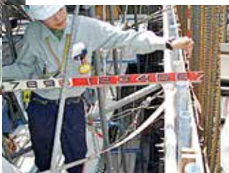
型枠の出来形(壁厚)の確認
