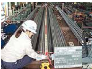
鉄筋の材料検収
