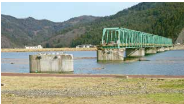
東日本大震災の津波で一部が流されてしまった橋。建設会社がいなければ、直すこともできない。
