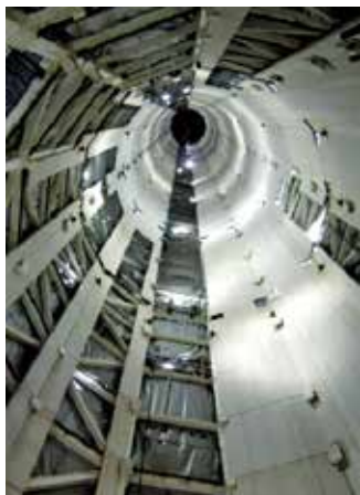
心柱が収まるタワー中心部。内径約10mの空間に直径約8mの心柱が構築されました
