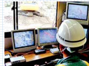
オペレーターは遠隔操作で建設機械を動かして作業する。
