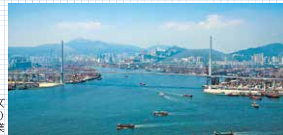
ストーンカッターズ 斜張橋(香港) 提供：前田建設工業
