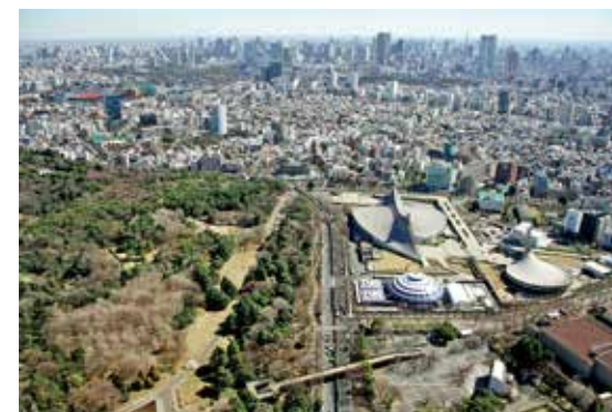
東京の街は、たくさんのインフラに支えられています。便利な生活ができているのも、建設会社がきちんと維持管理をしているからです。
