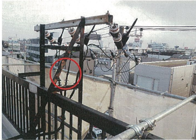
■事例2: 建物塗装作業中に高圧充電部に接触して感電
