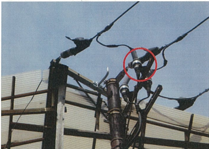
■事例3: 建物解体中にケーブルを切断して、地絡し感電の恐れ
