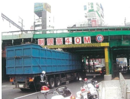
二葉橋ガード 外堀通り
