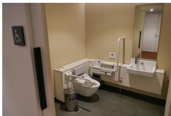
写真① 乳幼児用設備等のない車椅子利用者対応トイレ
