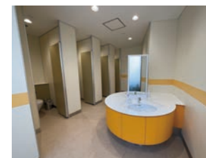
写真① 乾式の床、自動水栓
