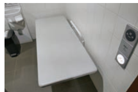
写真② 車椅子使用者対応トイレ (介助用ベッドあり)
