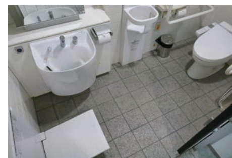
写真① 汚物流しが設置された個室
