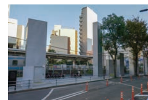
写真① トイレ外観
