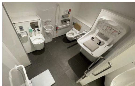
写真① 汚物流しが設置された個室（男性用トイレ）
