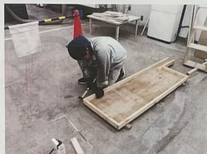
②柱型枠加工
