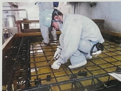
⑧床鉄筋組立（結束）
