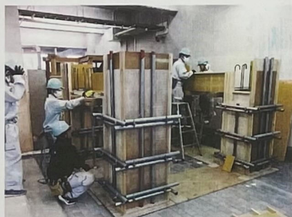
⑤柱・梁型枠組立
