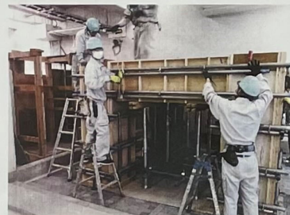
⑥梁・床型枠組立
