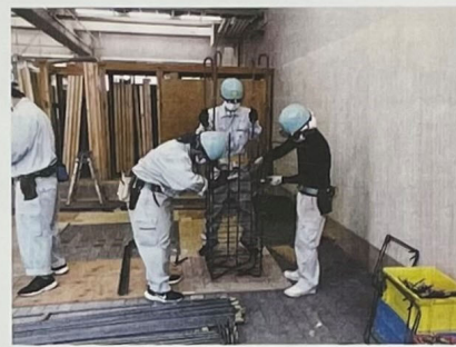
③柱鉄筋組立（フープ筋取付）
