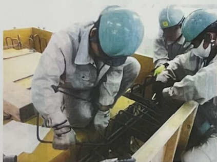
⑦梁鉄筋組立（スタラップ筋取付）
