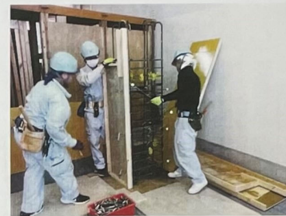
④柱型枠建て込み
