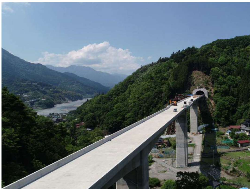
橋梁工事 (椿川橋の施工状況)
