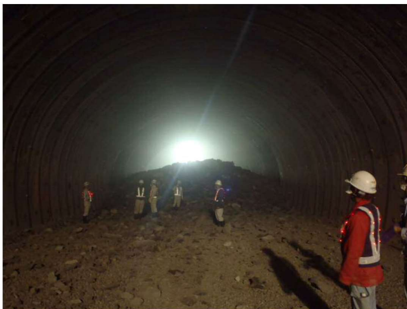
トンネル工事 (一色トンネルの施工状況)
