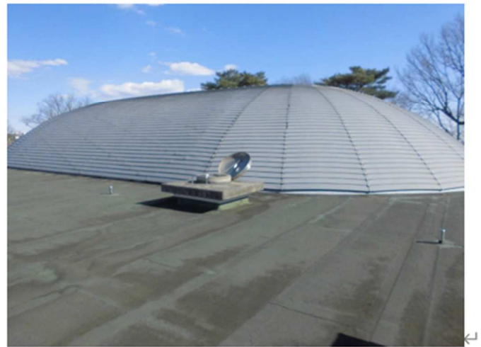
改修箇所（屋上） ←
