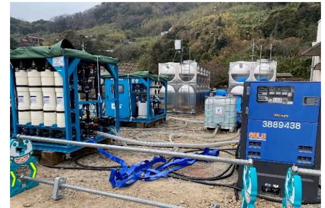
給水支援状況（2号機）
