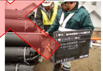
監督職員、現場技術員の臨場写真
