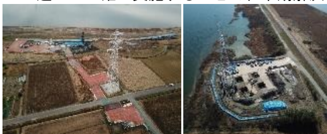
ドローン画像による現場状況確認
