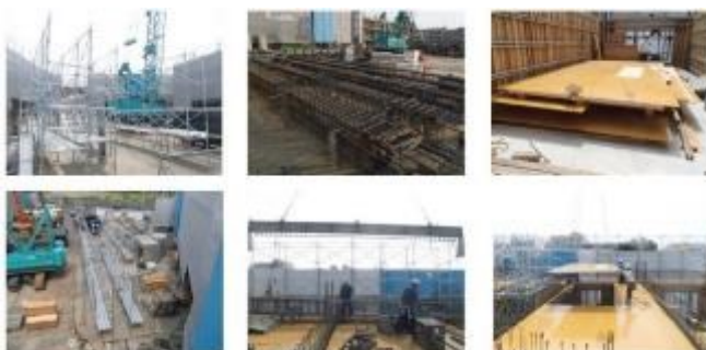
地組(足場・型枠・鉄筋)のイメージ
