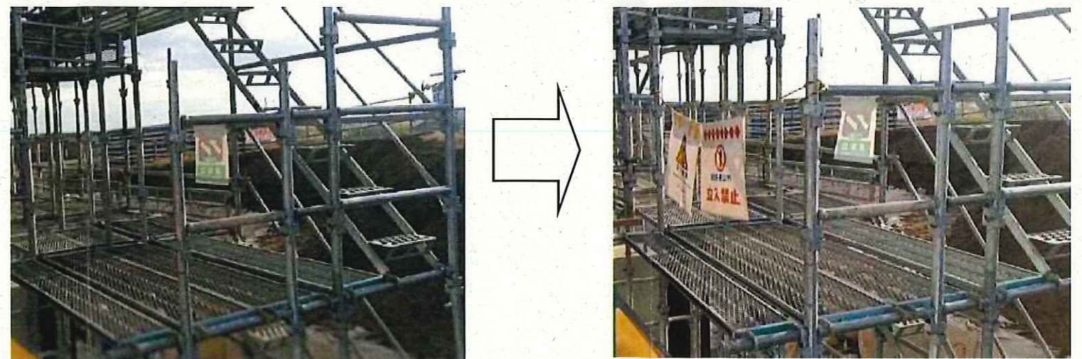
(解体足場への立入禁止措置を追加)
