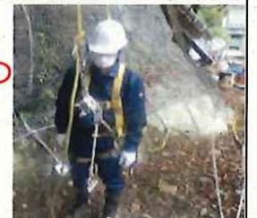
【墜落制止用器具の使用】
