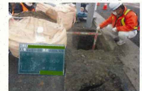
【試掘による確認】
