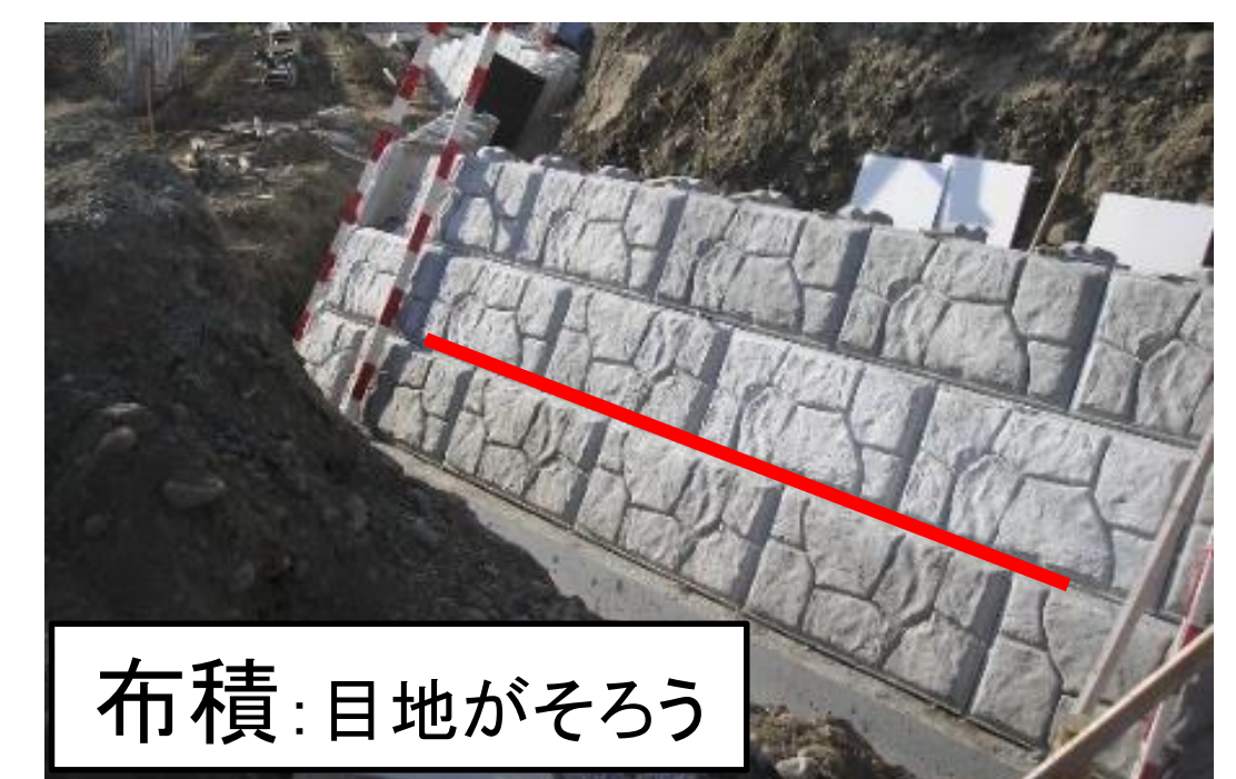
図2 控長35cmのまま大型化したブロックを布積にした形式
