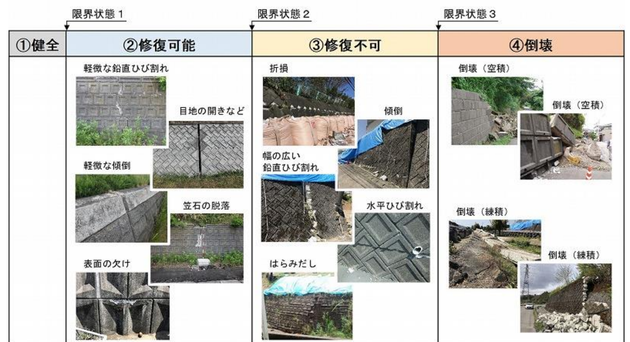
図3 変状事例に対する擁壁の状態の区分（例）
