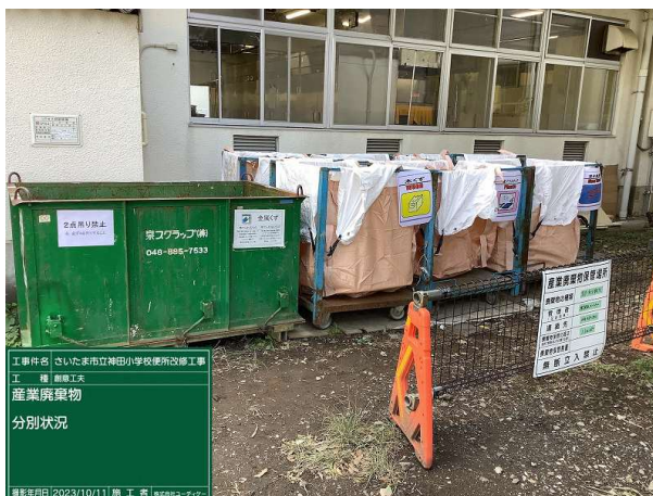
産業廃棄物分別状況(金属くず：コンテナ、他の3品目：フレコンバック)
