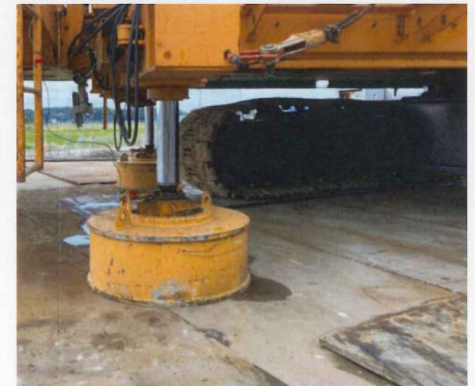
(アウトリガーの段差を解消)
