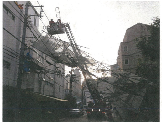
写真2 倒壊した足場の撤去作業状況
