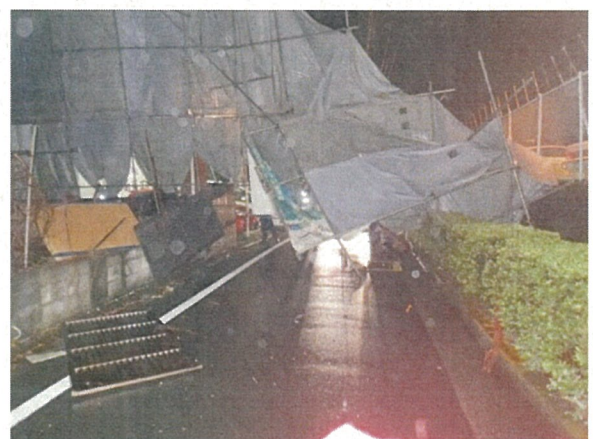
写真2 倒壊した足場が道路を塞いでいる状況
