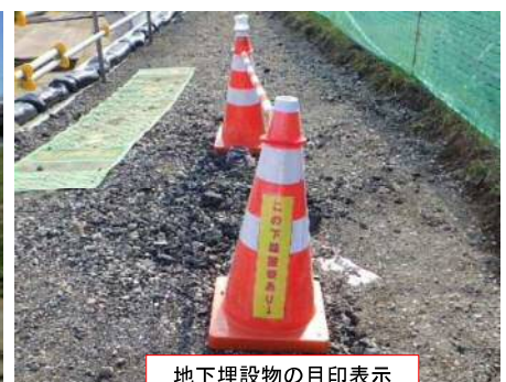
地下埋設物の目印表示
