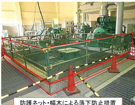
防護ネット・幅木による落下防止措置
