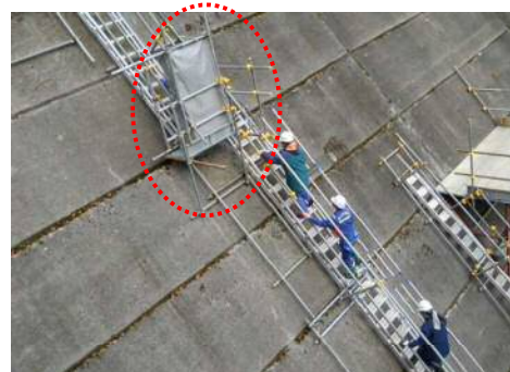
昇降設備の踊り場に転落防止ネットを設置
