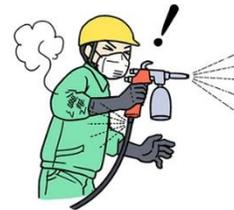
化学工場内における廃棄物焼却炉の定期補修工事で、耐火物へ耐火物の硬化時間促進剤である急結剤の吹付け作業を行っていた。その際、ノズルとホースの接続部から飛散した強アルカリの急結剤が作業員3名の皮膚に付着したことにより、3名とも薬傷（化学性皮膚炎）を負った。
