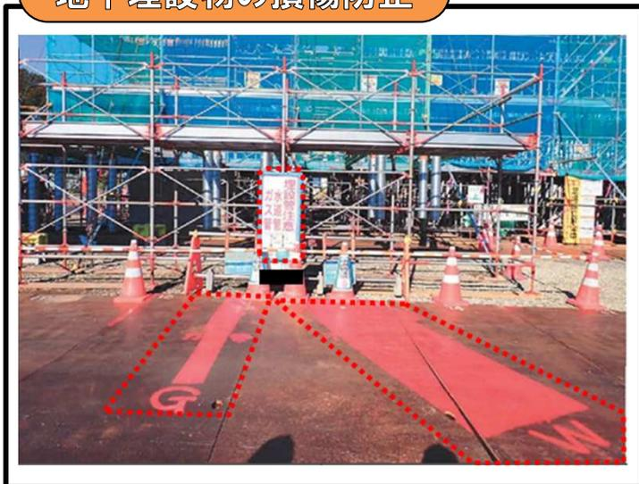
埋設位置の路面標示、注意喚起標識の設置
