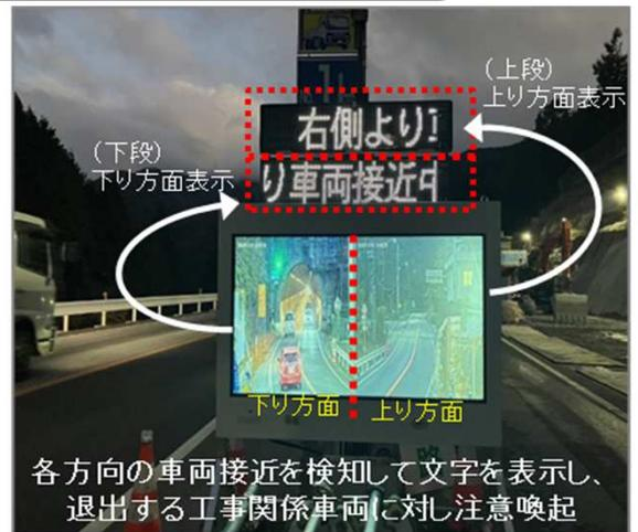
各方向の車両接近を検知して文字を表示し、
