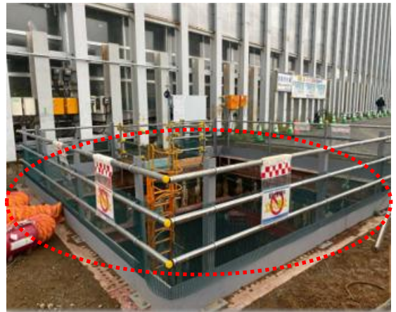
開口部をトリカルネット(目の細かいネット)で養生
