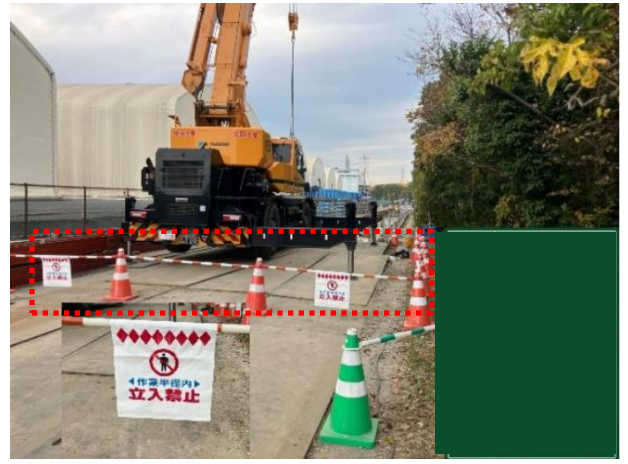
クレーンの作業半径内の立ち入り禁止措置
