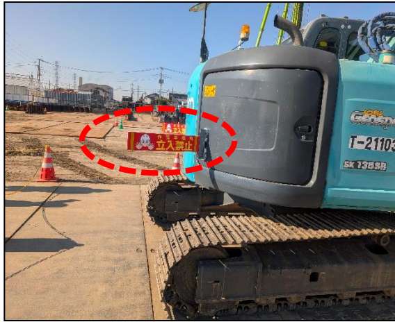
接触防止バーを設置
