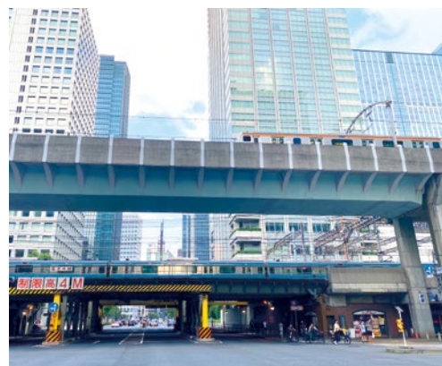
⑪ 呉服橋付近。新永間ガードのはるか上をゆく中央線の高架
