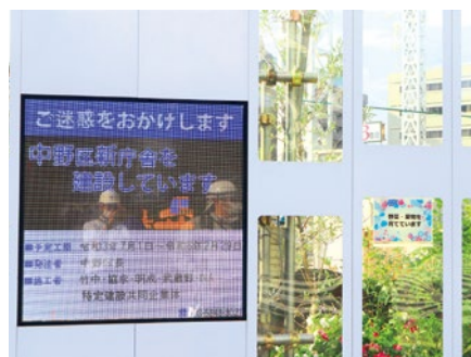
景観に配慮して仮囲いの中に植栽を実施。工事への協力に感謝し、デジタルサイネージにはメッセージを添える
