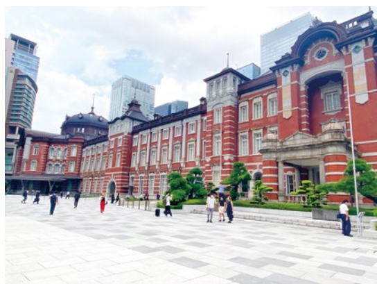
⑨ 2012年に創建時への復元工事が完成した東京駅赤レンガ駅舎
