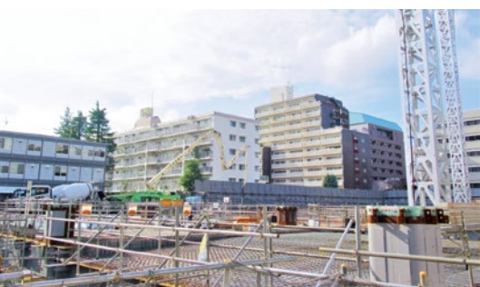
現場周囲にはマンション、学校が隣接しているため、作業時間など近隣との約束事を順守。現場リーダー会が主体となって周辺の清掃活動を行っている
