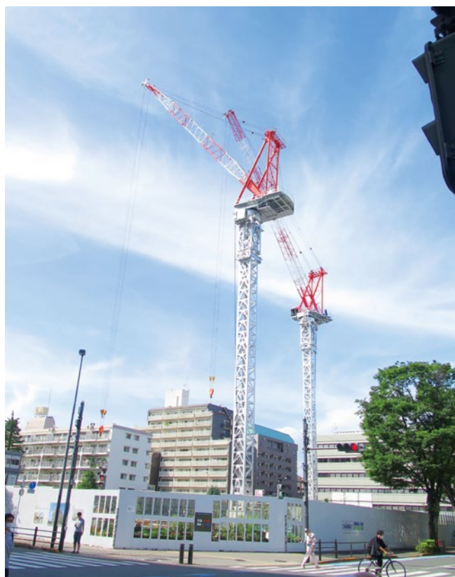
鉄骨の組み上げ工事が本格化し、年内には上棟する予定だ
