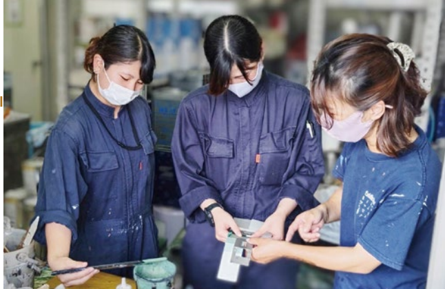
📌 施工前に塗料の調色を行う女性技能者
