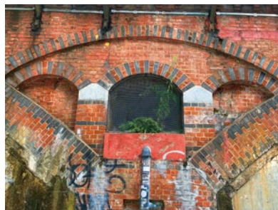
③ 径間12mアーチの間には開き窓の装飾がある
