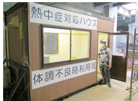
① 体調不良時にはすぐに駆け込めるよう、地下2階に熱中症対応ハウスを設置。常時冷房を入れ、飲料を備える
