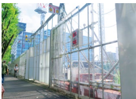
現場は中野駅に近く、通行人が多いため細心の注意が必要。中の状況が確認しやすいように仮囲いの一部で透明なアクリル板を使用する
