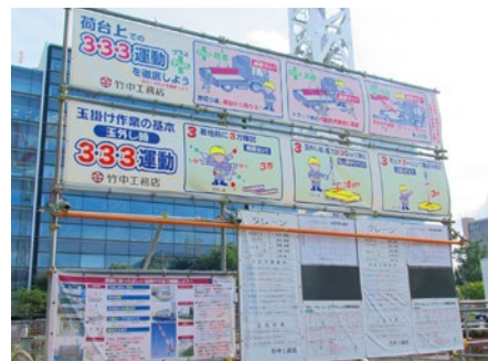
① クレーンの近くには玉掛け作業の基本を大きく掲示
