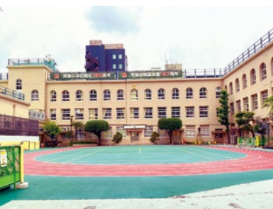
④ 中央区日本橋本石町の常盤小学校。明治6年開校だが、現在の校舎は昭和4年築の震災復興建築
