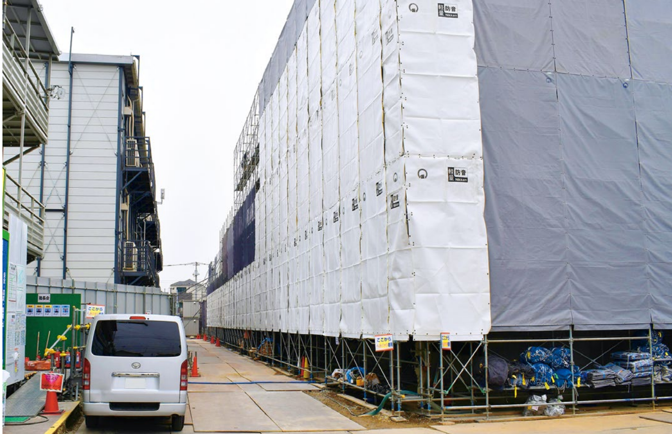
📍右側が新校舎。左奥の仮設校舎と近接しているため、仮設校舎側に防音シートを施し、作業を進めている
