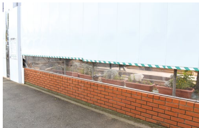
📍道路側からの仮囲いの下側部分をクリアパネルにし、花壇を設けた。周囲への癒し効果や、夜間は点灯させることで防犯灯の役割も果たしている
