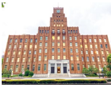
⑥ 市政会館。日比谷公会堂と一体化している建物。オフィスビルとしても運営されている。東京都選定歴史的建造物
