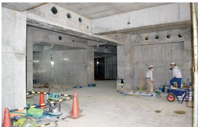
📍躯体が仕上がった内部。学校側からの要望で、内装工事前の校舎を児童たちに見学してもらう予定だ
