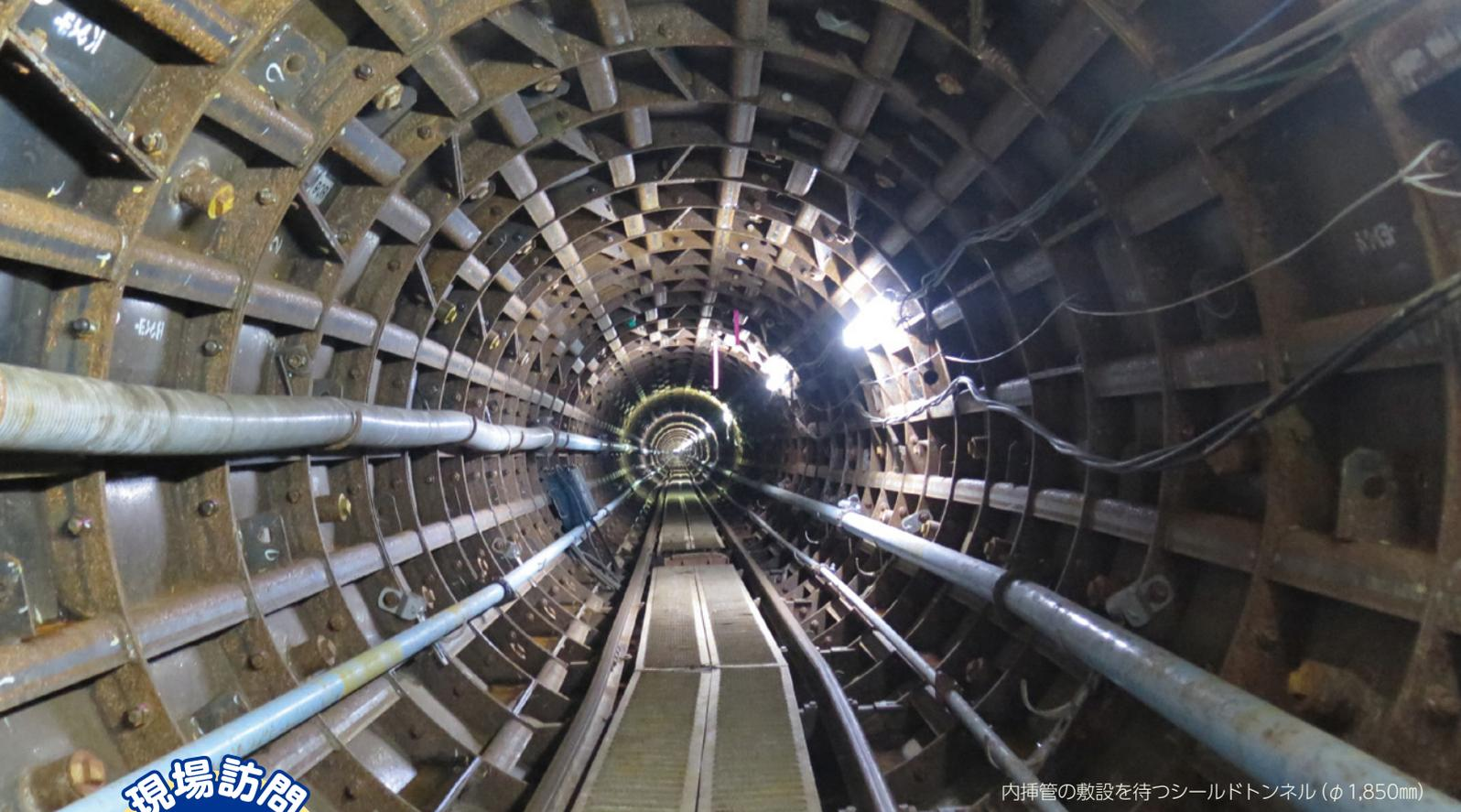
内挿管の敷設を待つシールドトンネル(φ1,850mm)
