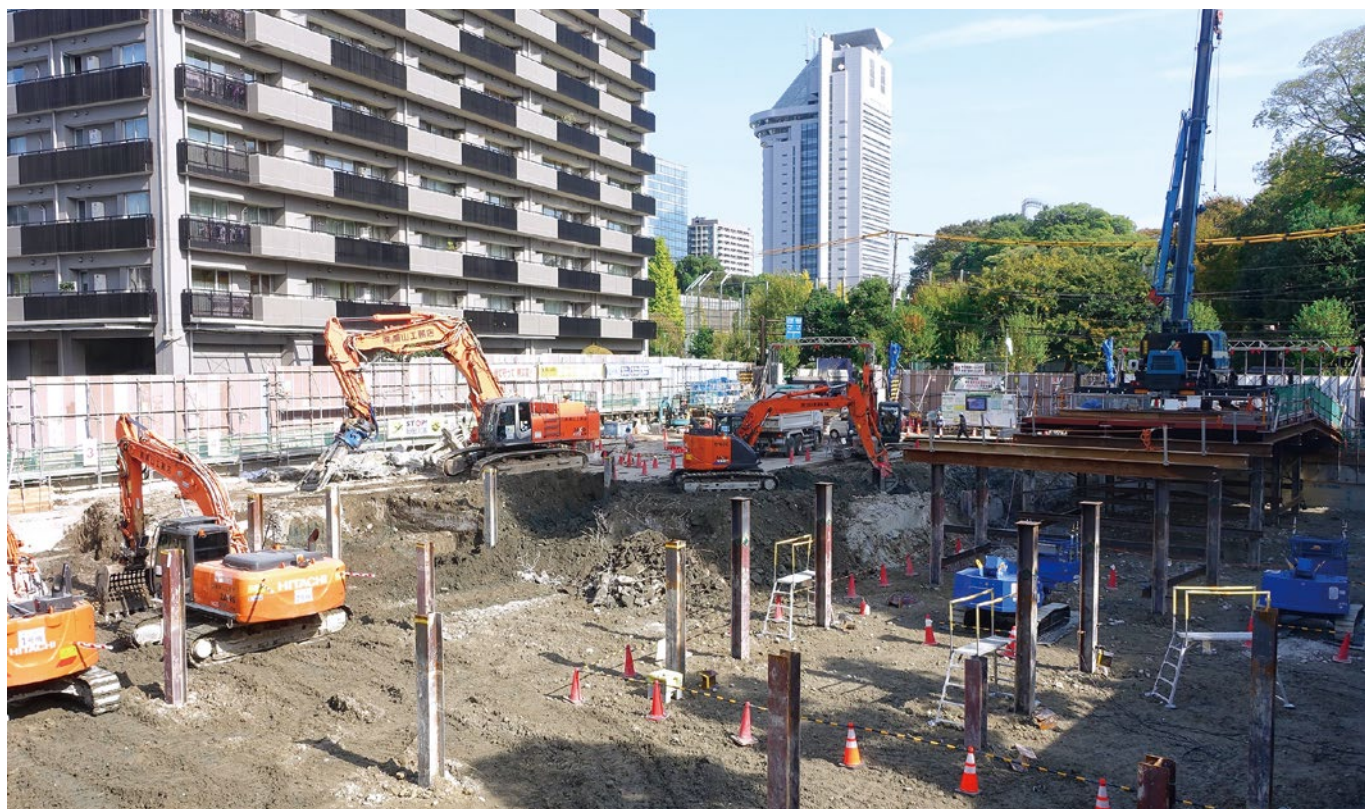
🔴現場全景。地下躯体の構築に向けて一次根切りを実施していた
