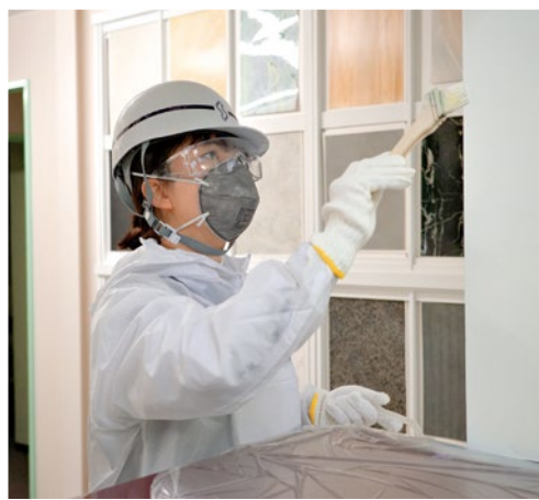
塗装作業時は手元に集中
