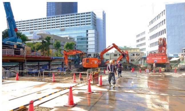
🔴粉じんの飛散を防止するため散水が欠かせない
