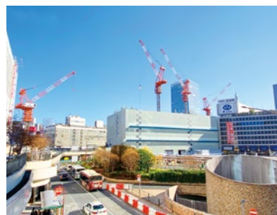
④新宿駅西口では、小田急百貨店本店の解体が進む
