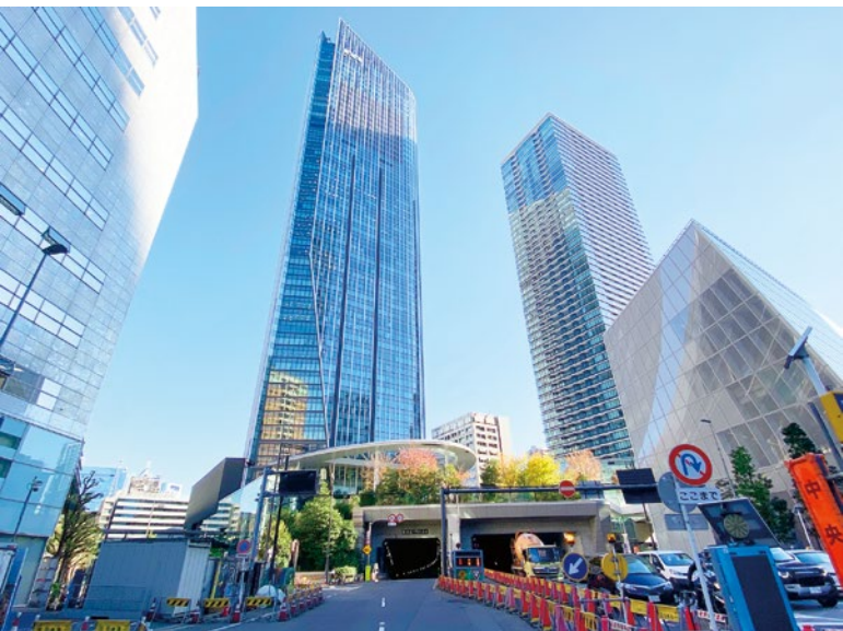
④ 計4棟の超高層が並び、虎ノ門ヒルズの完成となった
