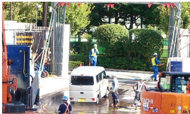
🔴場外に出る工事車両のタイヤ洗浄を徹底
