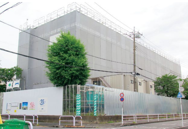
③躯体が5階まで立ち上がっている
