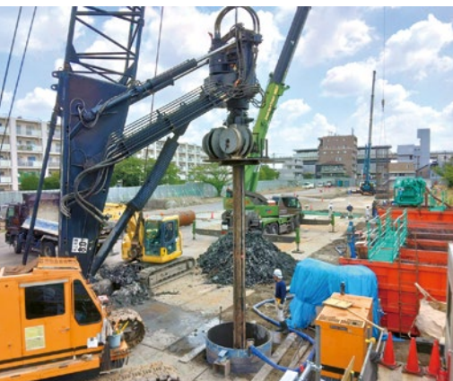
①日影がないため、杭打ち工事で熱中症対策に工夫を凝らした
