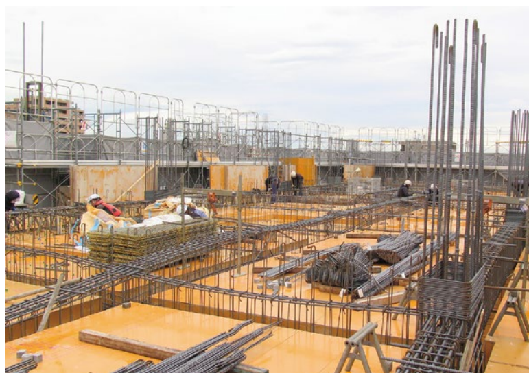
④5階床の配筋工事の真っ最中だった
