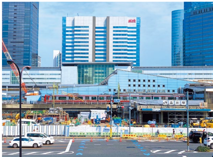
品川駅高輪口には、今後駅前に歩行者デッキが建設予定
