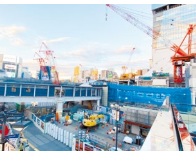
①渋谷駅西口。渋谷スクランブルスクエアの第二期工事が進んでいる
