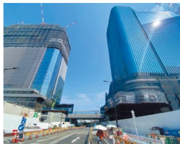
高輪ゲートウェイでは線路沿いに建物が出来上がりつつある
