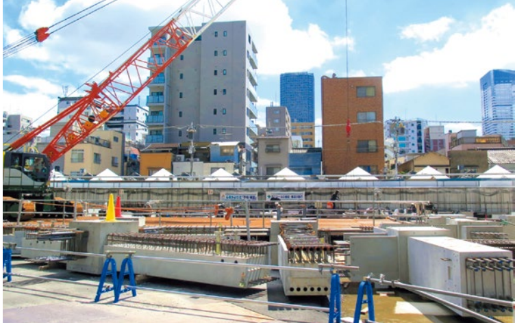
④PC部材は現場でも製作
