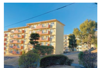
④諏訪2丁目。外壁が住棟ごとにカラフルな色でペイントされている一画
