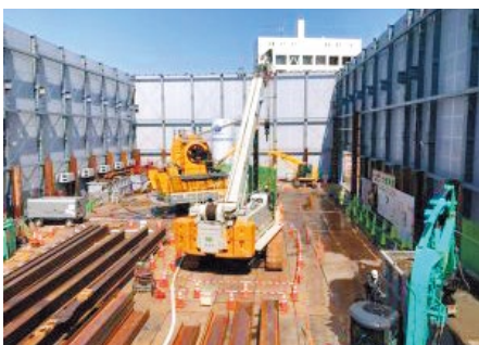
③発進立坑の地中連続壁工(2020年3月)
