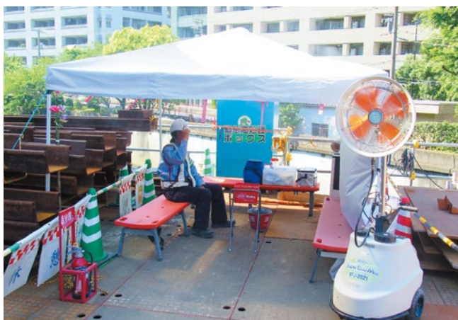
④仮栈橋の上にテントを構えてすぐに休憩できるようにした
