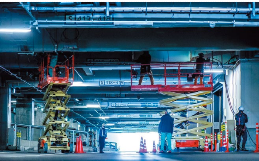
📍 施工现场の様子
