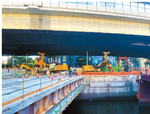
↑首都高の桁下空間は高さ5m。鋼矢板を溶接して継ぎ足しながらおよそ18mの深さまで打ち込む
