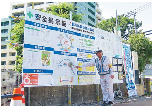
④仮栈橋の一角に置いた安全掲示板の前で朝礼を開いている
