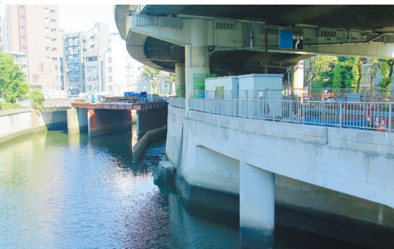
↑現場は流路が急カーブを描く「大曲」。江戸川橋分水路の吐き口(右)と水道橋分水路の取水口(左)の直下流で、上から首都高の高架が迫る
