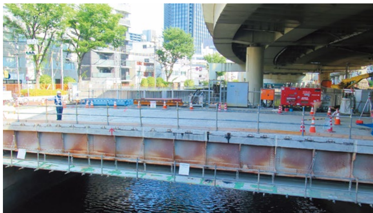
↑上流側から白鳥橋の上部工を3ステップに分けて撤去。1ステップ目を終えて隠れていた桁の側面があらわになった
