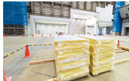
③ガラスウールを撤去したホール内の壁（奥上）と交換用のガラスウール（手前）
