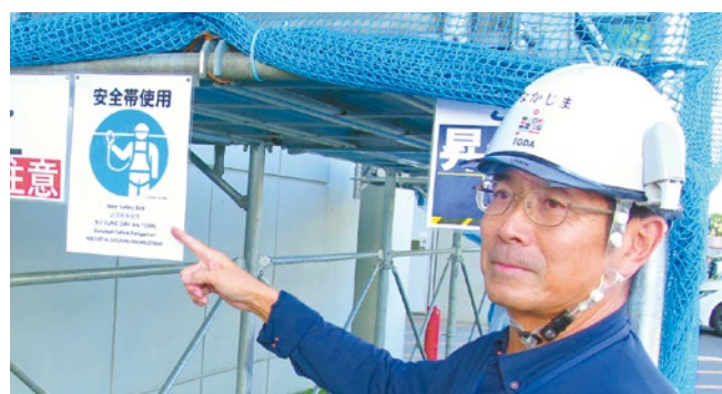
④「安全帯使用」を多言語で表示して外国人労働者に配慮している
