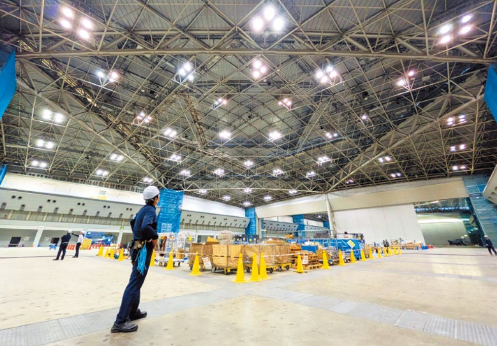
①改修中の東1ホール。天井高は最高31mある。別発注の電気設備工事で照明がLED化された
