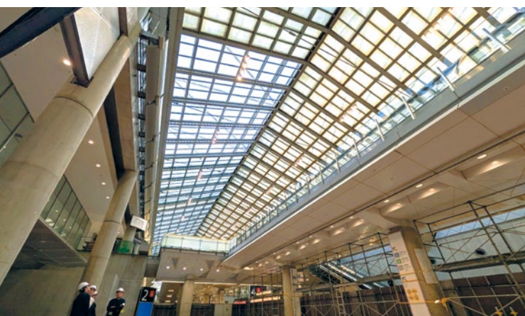
⑥屋根ガラスの遮熱・遮光改修では塗料をはがして代わりにフィルムを張る。色合いの違いで改修前（右側）と改修後（中央奥側）の状況が分かる
