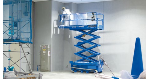
②ホール内の壁・柱の塗装を打ち放し風に塗り替え。高所作業車がスムーズな移動と安全な作業を可能にしている
